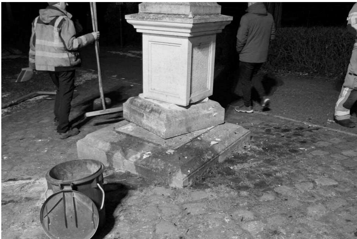
Die Säulenelemente wurden verschoben, glücklicherweise kippte die Skulptur aber nicht um. © Medienportal Grimma/Sören Müller
